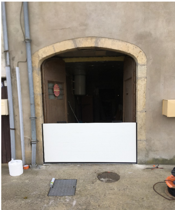
Barrière anti-inondation installée à Espalion (Aveyron) par l'entreprise Isoal Isoflots ©Mairie d'Espalion
