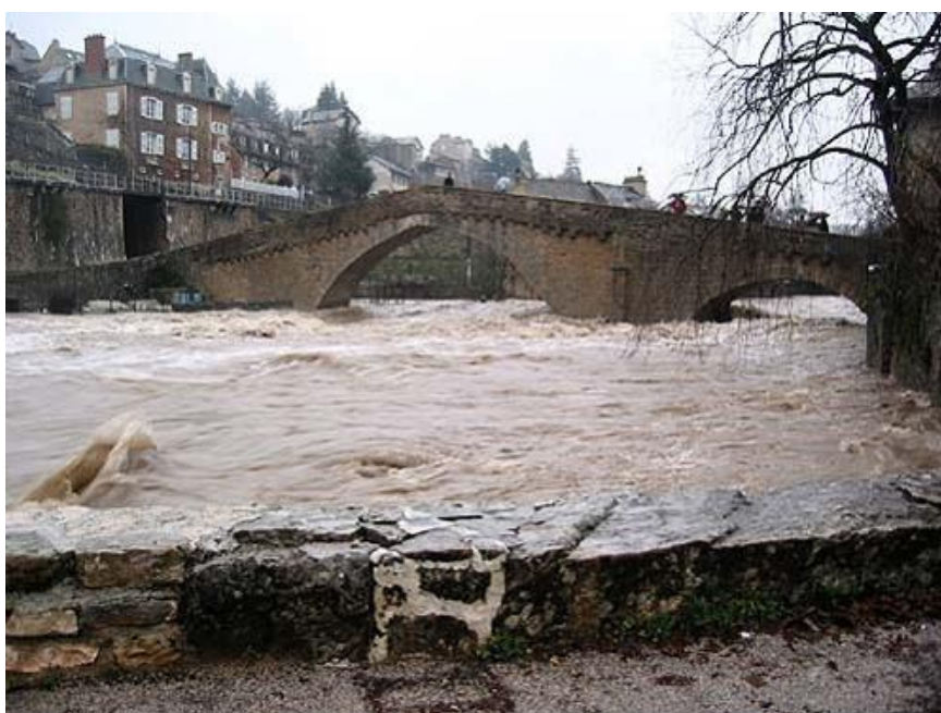
Figure 10 : Crue du Lot en décembre 2003 au niveau du Pont Notre Dame à Mende (photo : Association Hors d'Eau).
