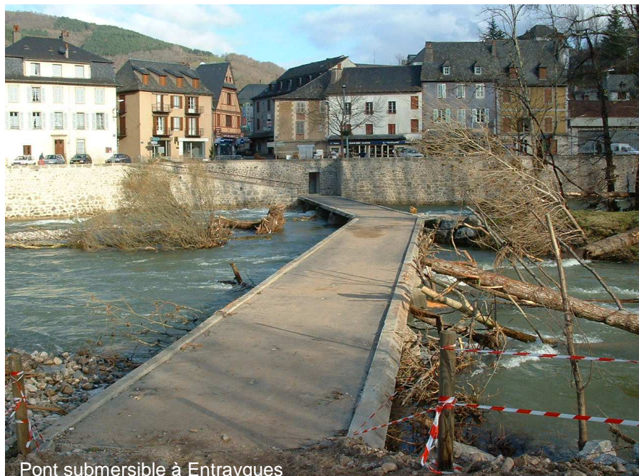
Pont submersible à Entraygues
