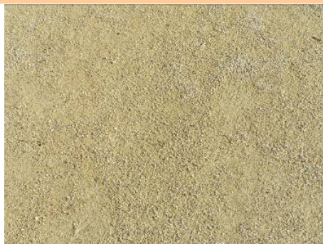
Détail du revêtement
