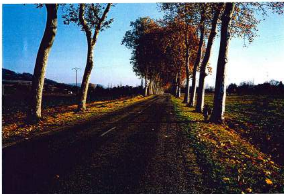
47-10 (n°2-5A)- D911 avant le pont de Roussanes : 0,7 km à sécuriser
