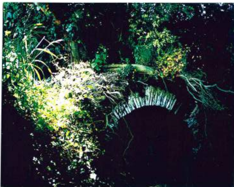
47-19 (n°4-18A)- Casseneuil- Ancien pont sur le ruisseau de Taillepié: le réhabiliter ou construire une passerelle à cet endroit
