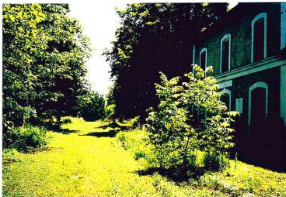
47-21 (n°4-30A)- Casseneuil- ancienne gare : à ré-habiter pour la Véloroute
