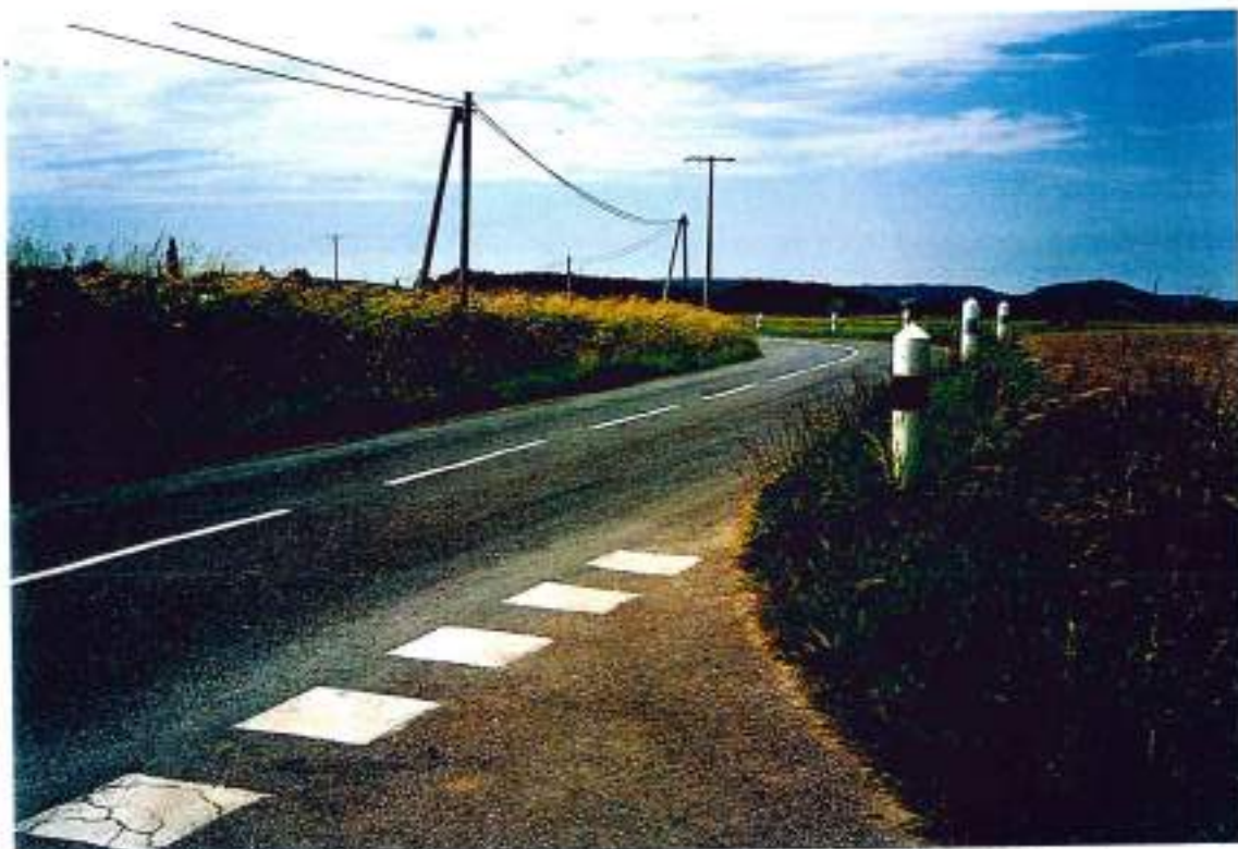
47-44 (n°5-19)- La D243 au carrefour Clauzade: à sécuriser jusqu'à Séguy (2,5 km)
