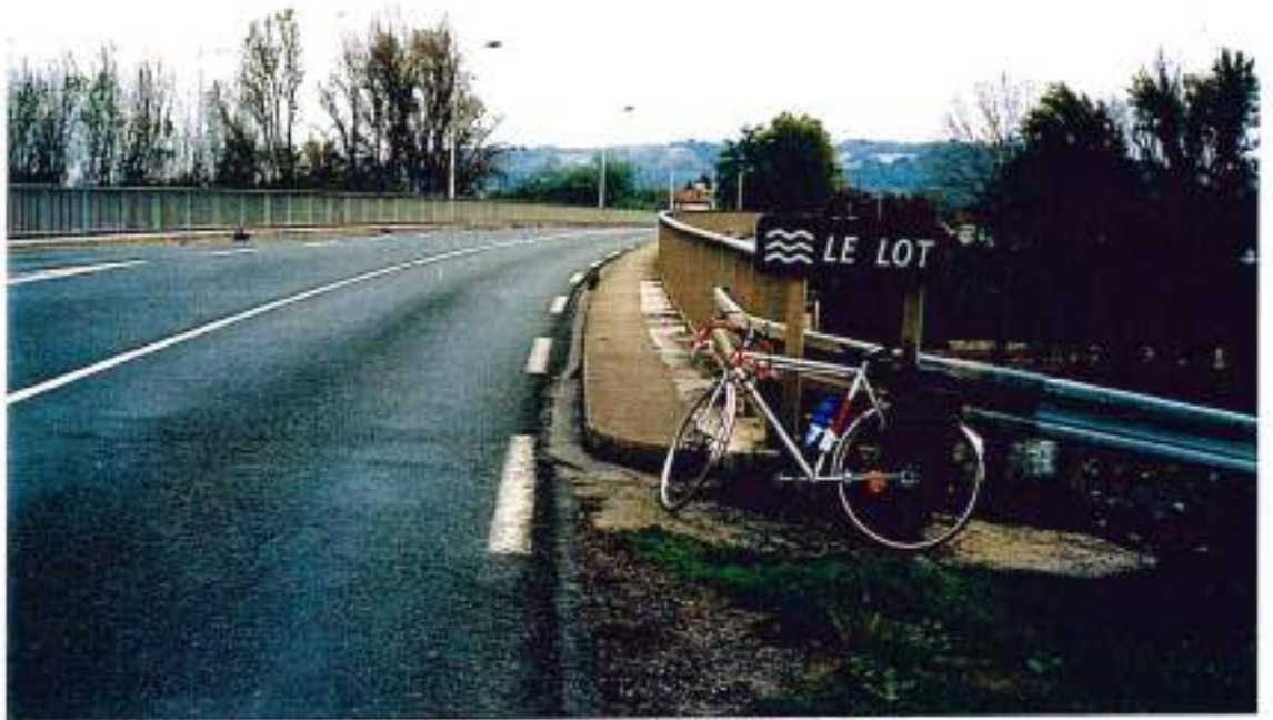
47-5 (n°1-27A)- Pont de la RN113 à Aiguillon : à sécuriser
