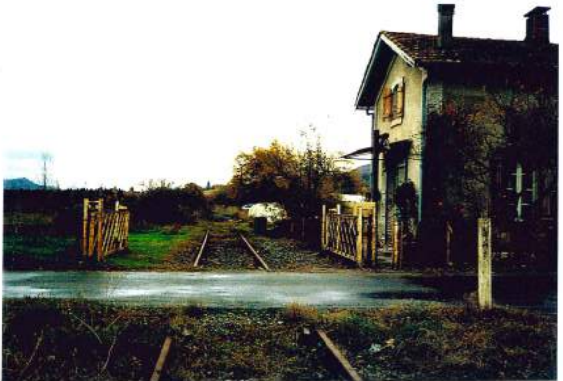
47-34 (n°5-5-11)- Future Voie Verte de liaison entre Château Rogé et Penne-d'Agenais sur ancienne voie ferrée (1,8 km): le début au passage à niveau Sablous
