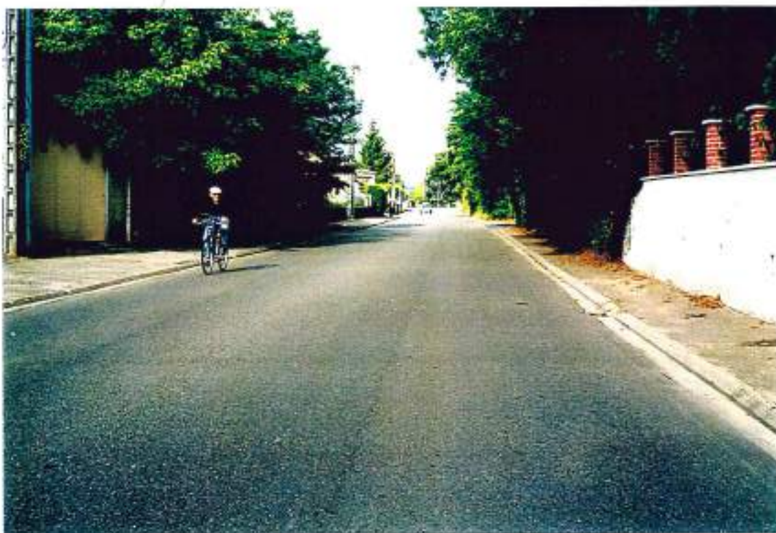
47-27 (n°5-14)- Villeneuve-sur-Lot- Avenue de la Myre Mory au n°42: chaussée de 7m sans marquages, à sécuriser par des bandes cyclables
