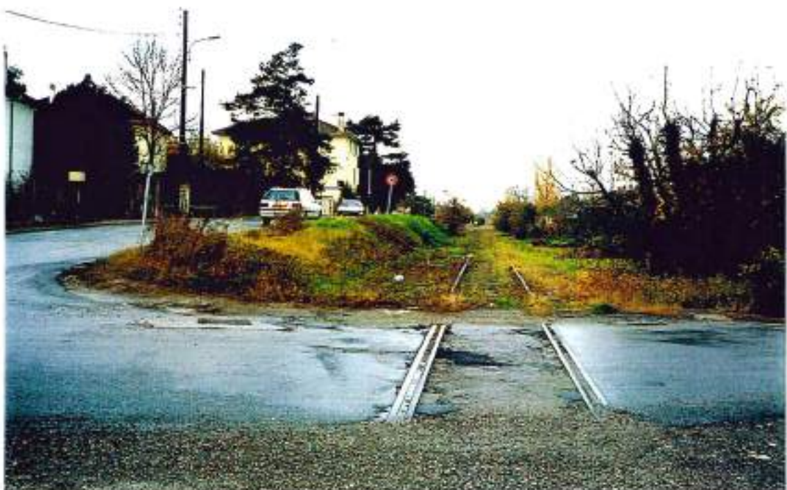
47-38 (n°5-5-4)- Villeneuve-sur-Lot, ancienne voie ferrée au LEP Couffignal (ZI): itinéraire "futur" de complément possible de Villeneuve à Sablous
