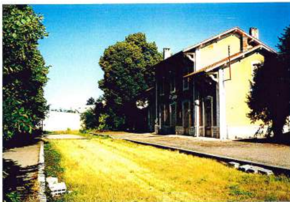
47-25 (n°3-22A)- Ste Livrade- Ancienne gare: à utiliser pour la Véloroute
