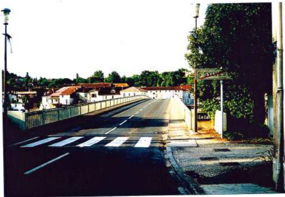
47-30 (n°5-6)- Pont de St-Sylvestre-sur-Lot: à sécuriser par marquage de files, ligne médiane continue et bandes cyclables étroites
