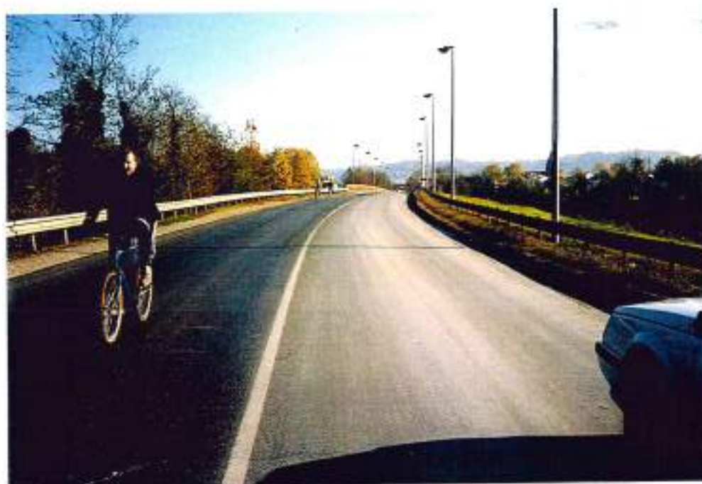
47-14 (n°2-18A)- D667 au pont avant Ste-Livrade-sur-Lot: à sécuriser sur 700m
