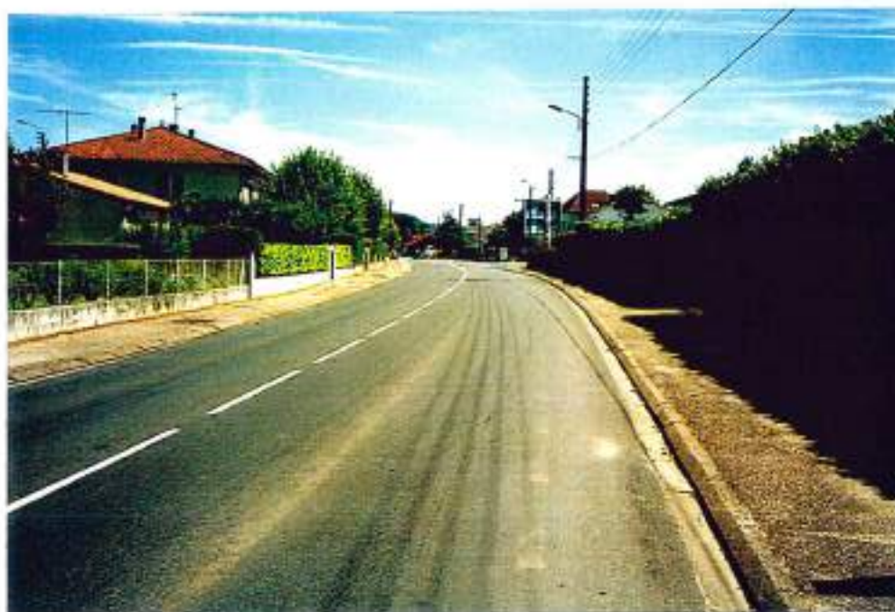
47-24 (n°4-36A)- Villeneuve-sur-Lot avenue de Bias : à sécuriser par des bandes cyclables (largeurs au n°77/92: 1,92m - 3,60m - 3,85m - 3m)
