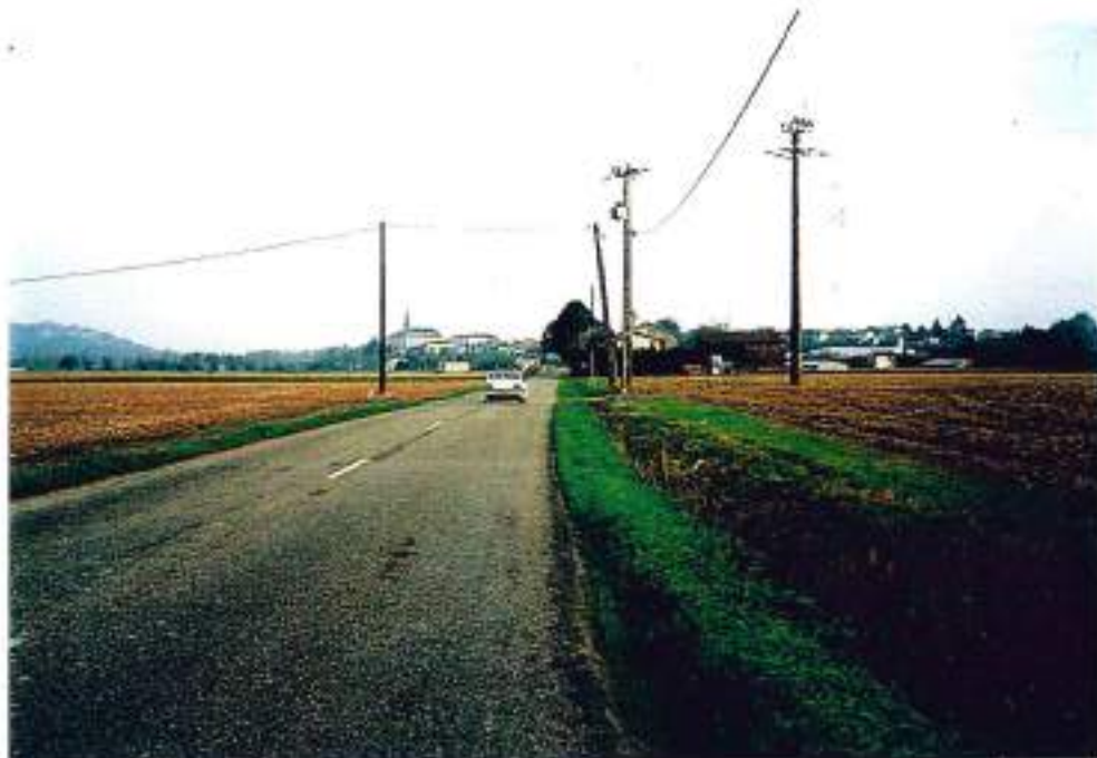
47-3 (n°1-18A)- D642 entre St-Léger et Aiguillon : 1,4 km à sécuriser
