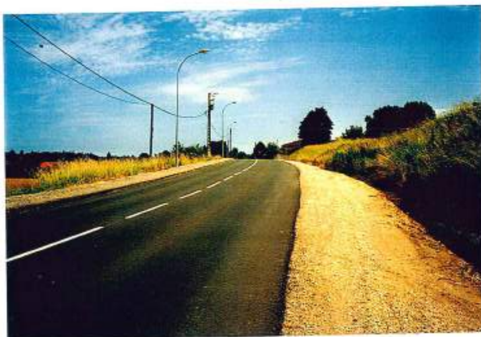
47-45 (n°5-23)- D243 entre St-Vite et Liboussou : à sécuriser (1,2 km)
