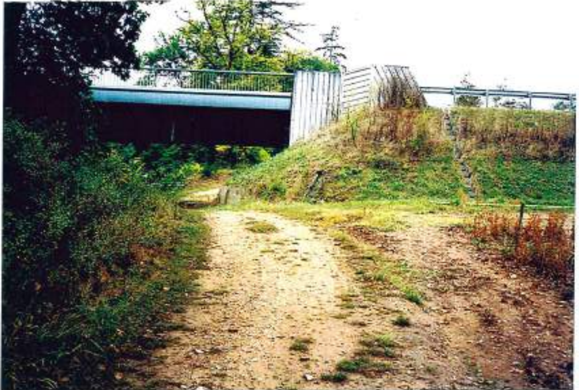
47-51 (n°5-4-27A)- Chemin de halage rive droite de l'écluse des Ondes à Libos : chemin existant déjà de Lamothe à Libos sur 1,2 km (itinéraire "futur")
