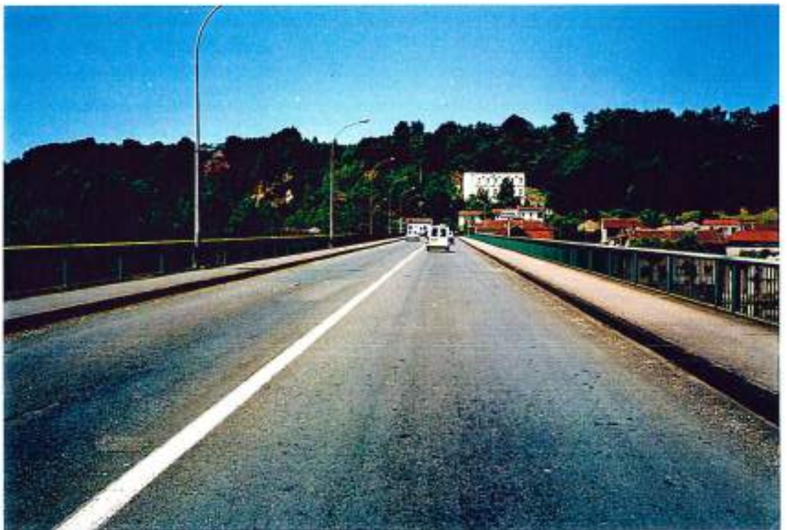
47-52 (n°5-30)- Pont de Fumel D139 avenue de Fumel : à sécuriser (chaussée disponible très large)
