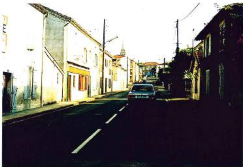
47-29 (n°5-5)- St-Sylvestre-sur-Lot: D103 rue descendant au pont: à sécuriser par marquage de files, ligne médiane continue et bandes cyclables étroites
