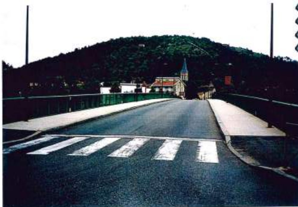
46-51 (n°12-8A)- Cahors- Pont de Cabessut, 12000 véh/j, aucun marquage: à sécuriser
