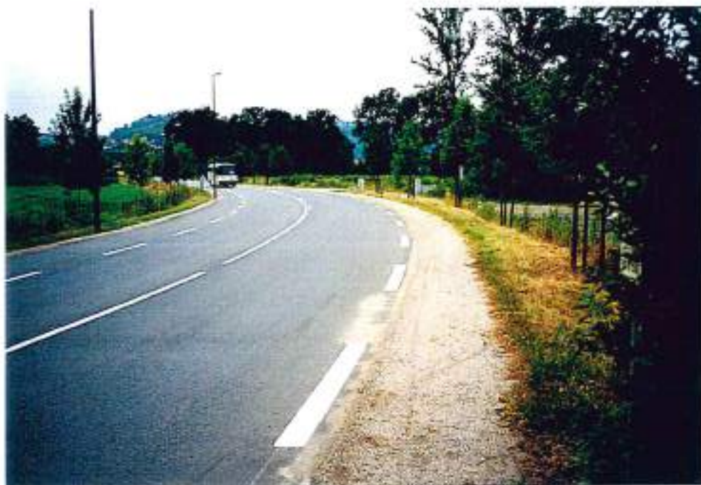
46-89 (n° 18-29A)- La D86 Bd F. Mitterand à Capdenac-Gare : à sécuriser
