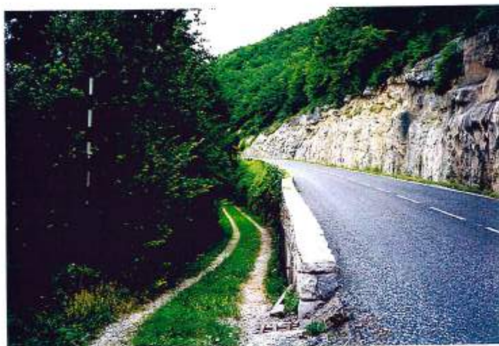
46-32 (n°11-26A)- D8 après Douelle vers Cahors (tronçon A): l'accès à la route parallèle vers Flaynac évitant la D8 sur 500m, privatisée en contre-bas
