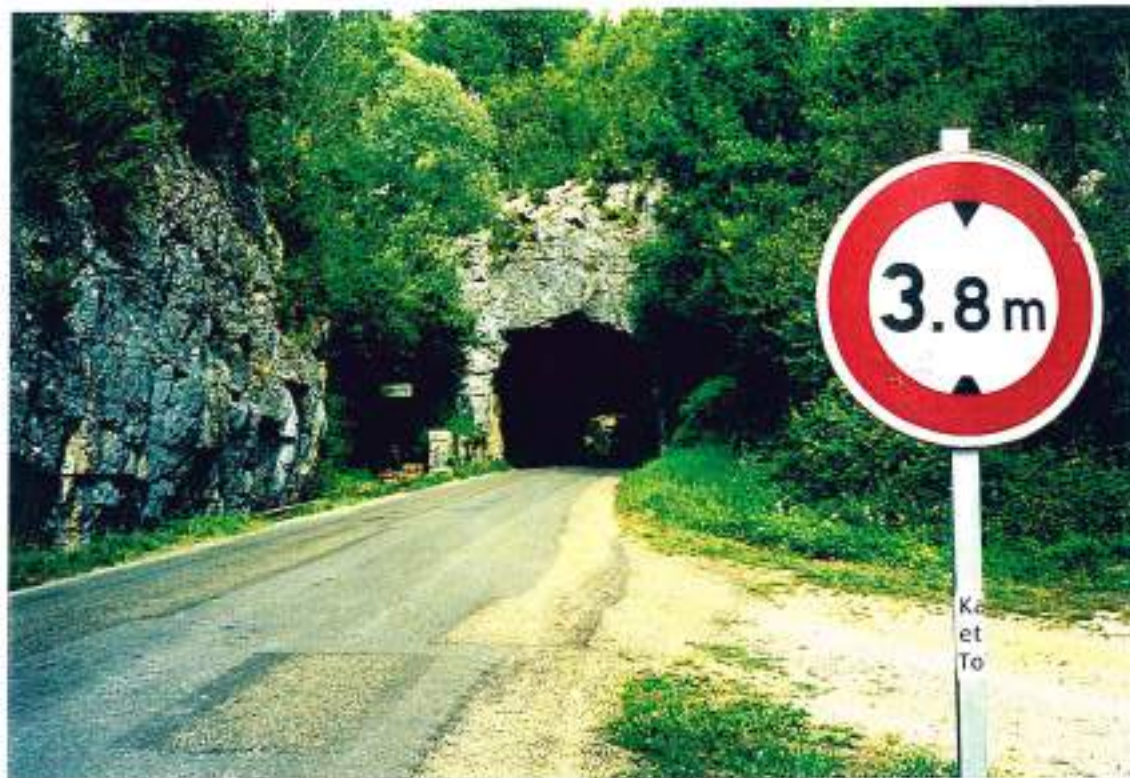
46-71 (n°15ter-11A)- Vallée du Célé- D41- Tunnel de La Pescalerie : à sécuriser par signalisation, limitation de vitesse, éclairage permanent.
