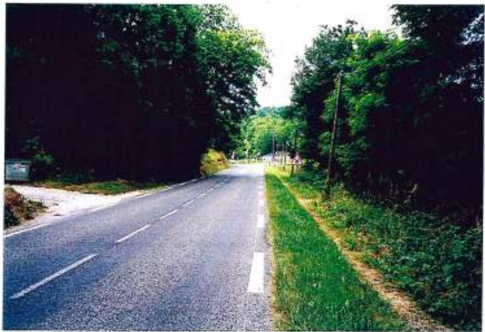
46-33 (n°11-16A)- D8 vers Flaynac, carrefour avec C6 : tronçon C à sécuriser
