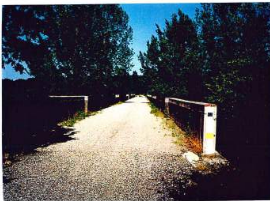
46-40 (n°11-21/21A)- Voie Verte existante de Douelle à Mercuès (5 km) : le pont SNCF sur le Lot
