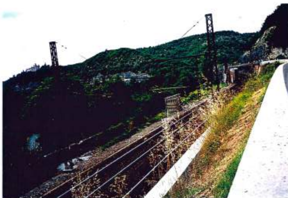
46-44 (n°11-10/10A)- Future liaison Mercuès-Cahors Englandières: l'emprise disponible, parallèle à la voie ferrée, après le pont D911 sur voie ferrée
