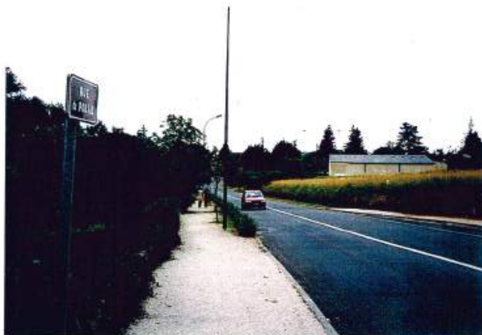
46-35 (n°11-2/2A)- Pradines -rue de Poujal : la D8 (tronçon D) à sécuriser
