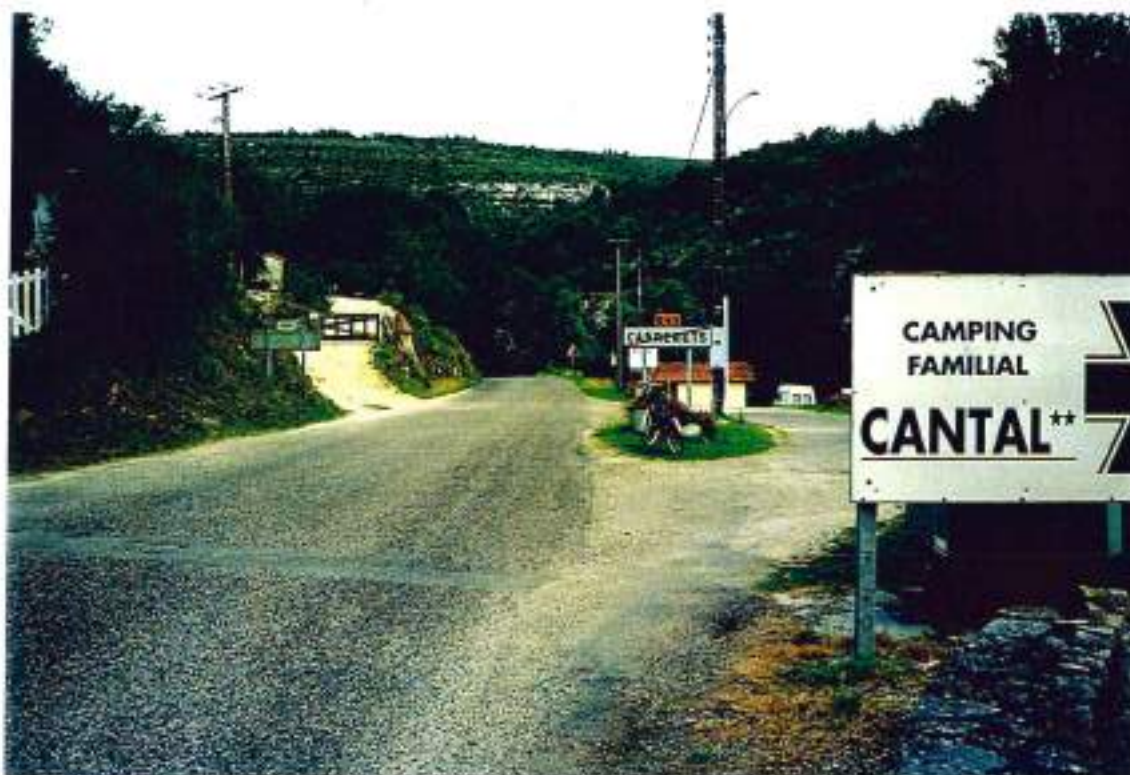
46-70 (n°15ter-8A)- Vallée du Célé- La D41 à la sortie de Cabrerets: étroite (5 m), pas de marquage de files, pas de bas-côtés. A sécuriser
