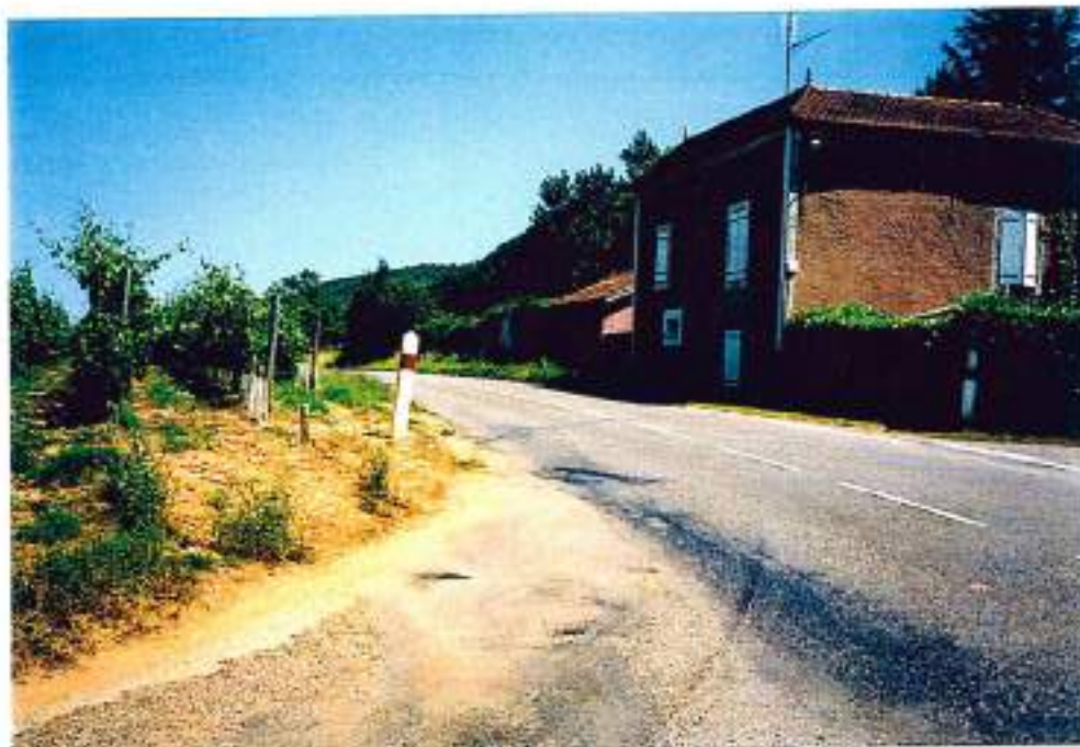
46-25 (n°10-9/9A)- Parnac-Cels- Le carrefour dangereux avec la D8: à éviter par aménagement de l'ancienne voie ferrée
