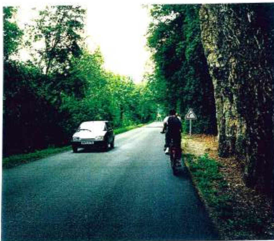
46-69 (n°15ter-4A)- Vallée du Célé- La D41 près de Conduché: étroite (5,20 m), pas de marquage de files, pas de bas-côtés. A sécuriser
