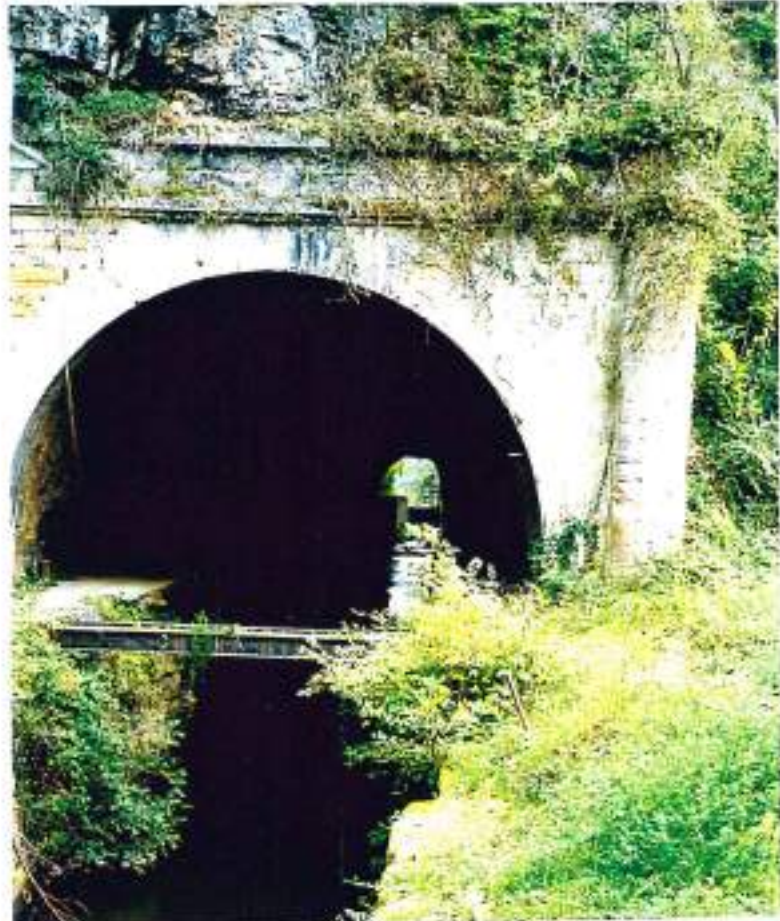
46-95 (n° 17bis-32)- Capdenac-le-Haut- Ancien tunnel navigable de Vic: site pour la Véloroute sur l'itinéraire "futur" rive droite La Madeleine-Capdenac
