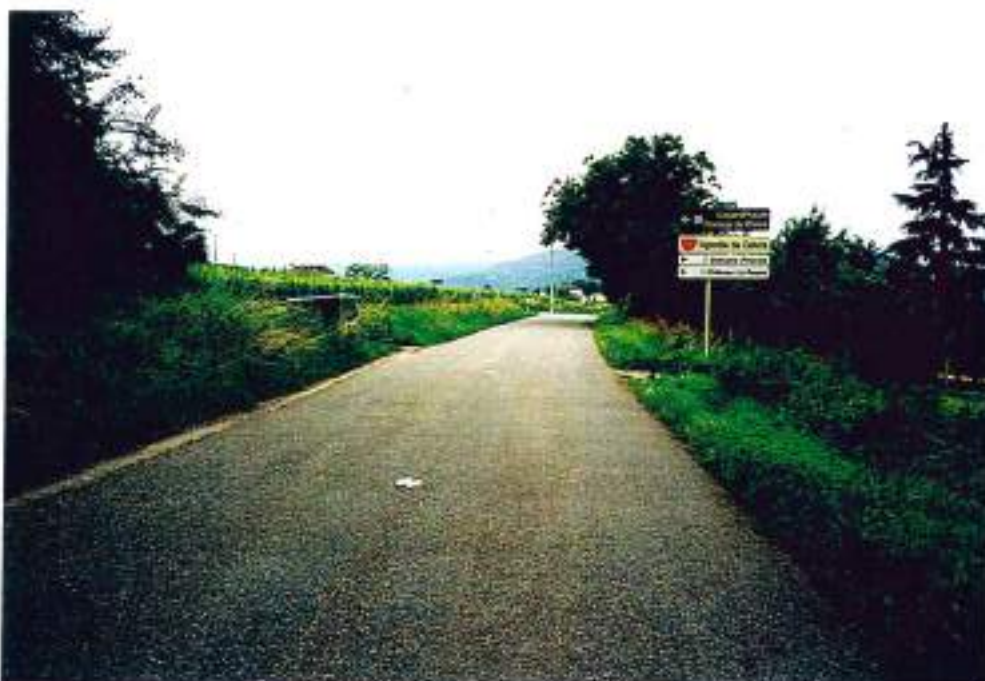
46-7 (n°7-2°-31)- D44 de Puy l'Evêque vers Grézels : à sécuriser par marquage de files ou élargissement de la chaussée et sur-largeurs (2,5 km)
