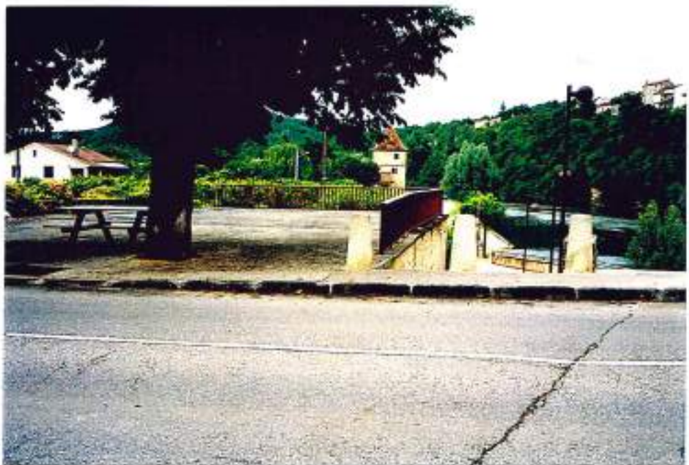
46-4 (n°7-2°-5)- L'arrivée de l'itinéraire au pied du pont de Puy l'Evêque : à sécuriser
