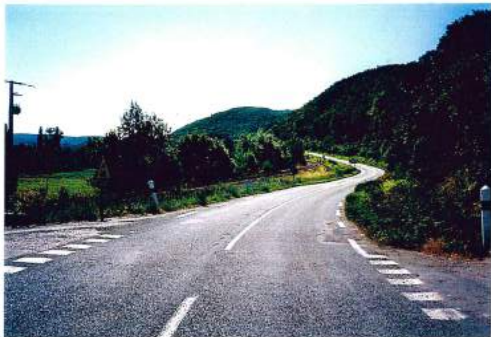
46-53 (n°14-36/36A)- La D911 du carrefour Cavaniès à l'écluse d'Arcambal: 1,3 km dangereux à sécuriser ou éviter en aménageant le chemin de halage
