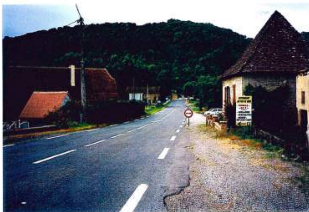
46-84 (n°17-12A)- La D922 entre le chemin vers Gaillot et le pont de La Madeleine: 700m dangereux, à sécuriser (il y a la place, chaussée de 6,30m)
