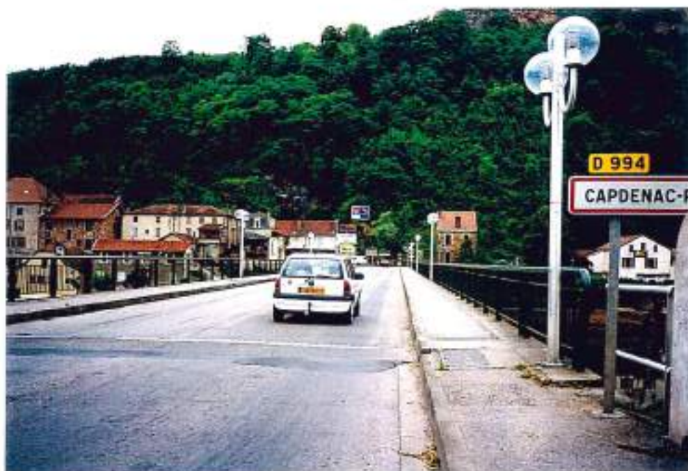
46-91 (n° 18-36A)- Pont D994 à Capdenac-Gare: à sécuriser par bandes cyclables de 1 mètre de large
