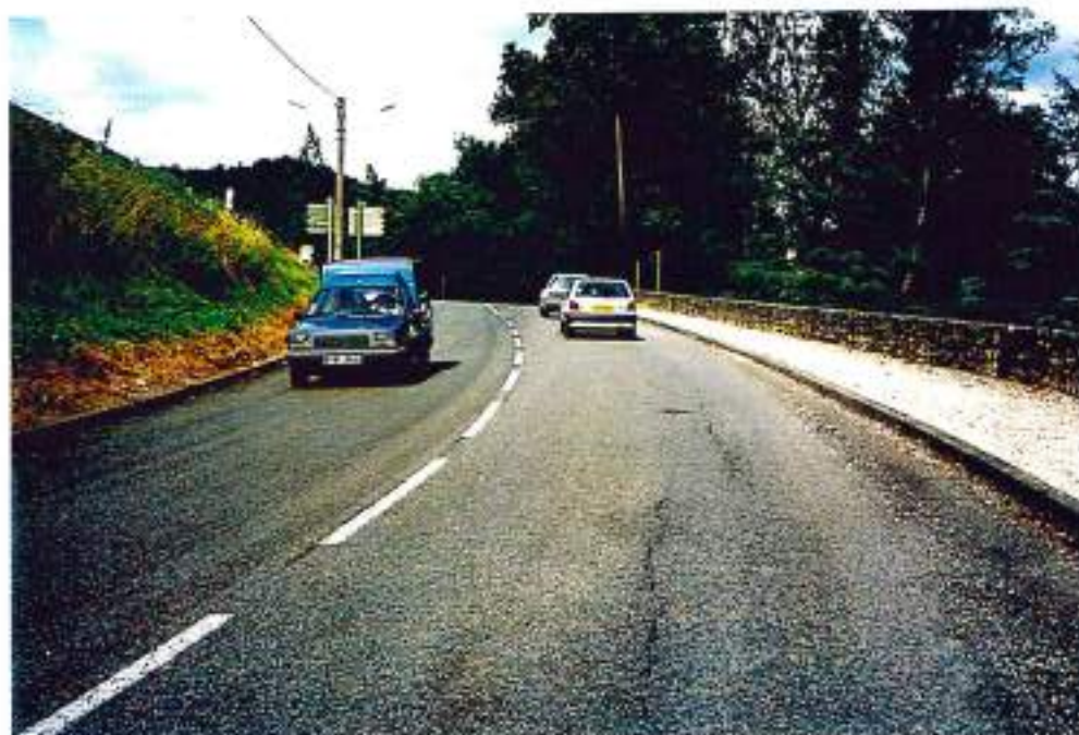
46-6 (n°7-2°-9)- Puy l'Evêque, rue des Platanes : à sécuriser par bandes cyclables de 1m
