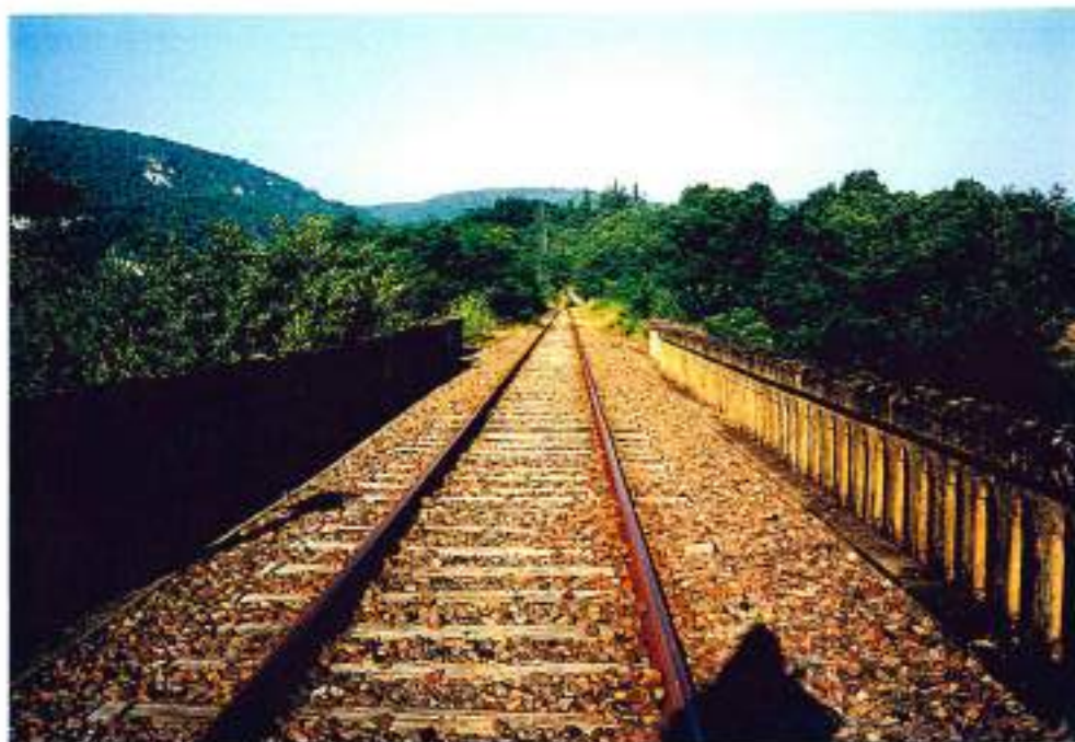
46-65 (n°15-11A)- Le pont de la voie ferrée à St-Géry/Les Masseries : vue en direction de l'accès côté D662 et V2 Les Masseries
