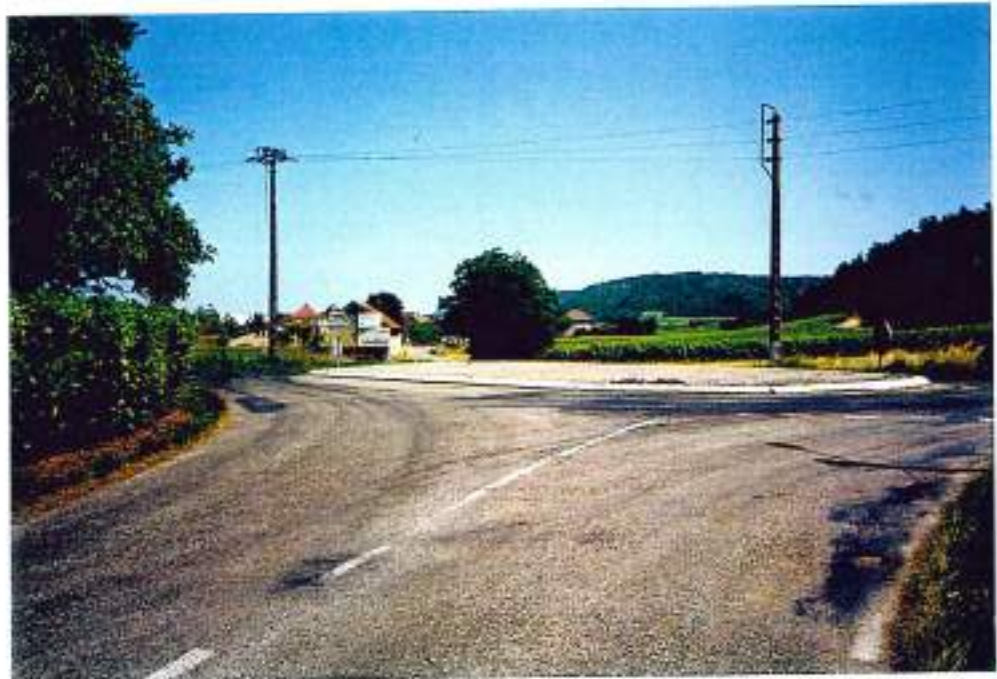
46-24 (n°10-7A)- Parnac- carrefour D23/D8 : à sécuriser pour éviter la D8
