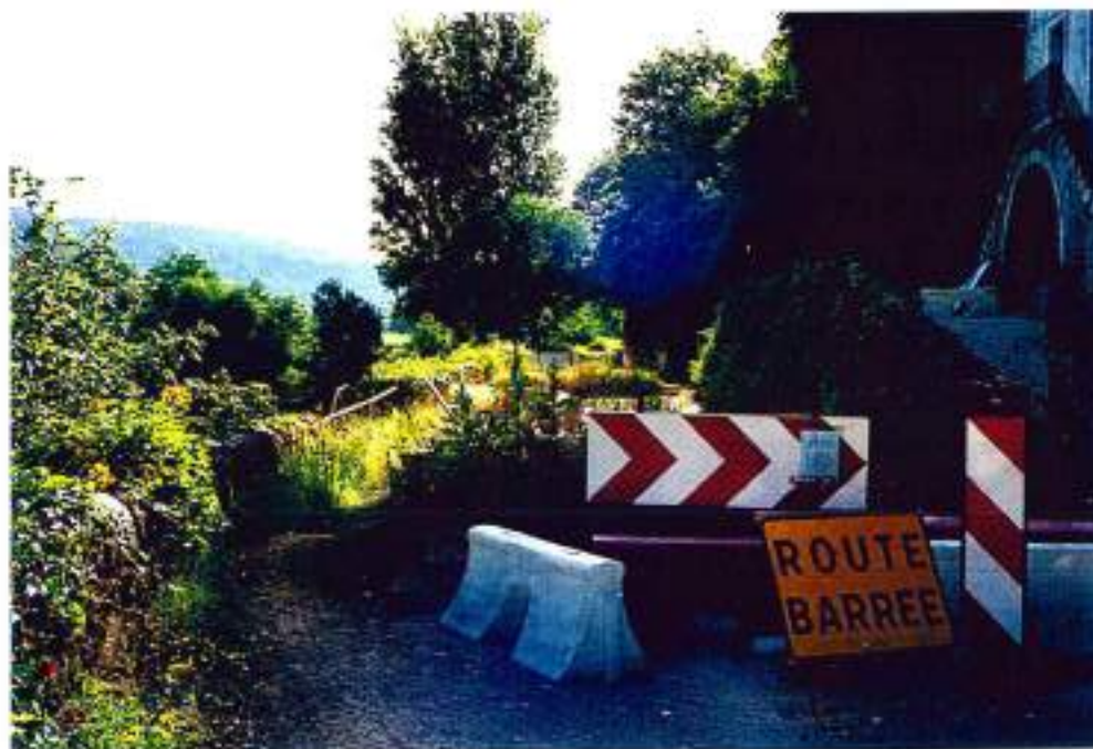
46-76 (n°16-5A)- La D8 après Crégols, route barrée à l'ancienne écluse : autoriser le passage des vélos (photo du 27-06-2000)
