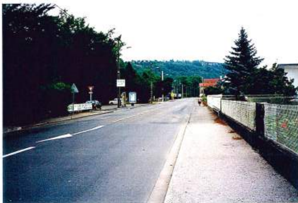
46-90 (n° 18-34A)- La D86 Bd P. Ramadier, face au camping, à Capdenac-Gare : à sécuriser
