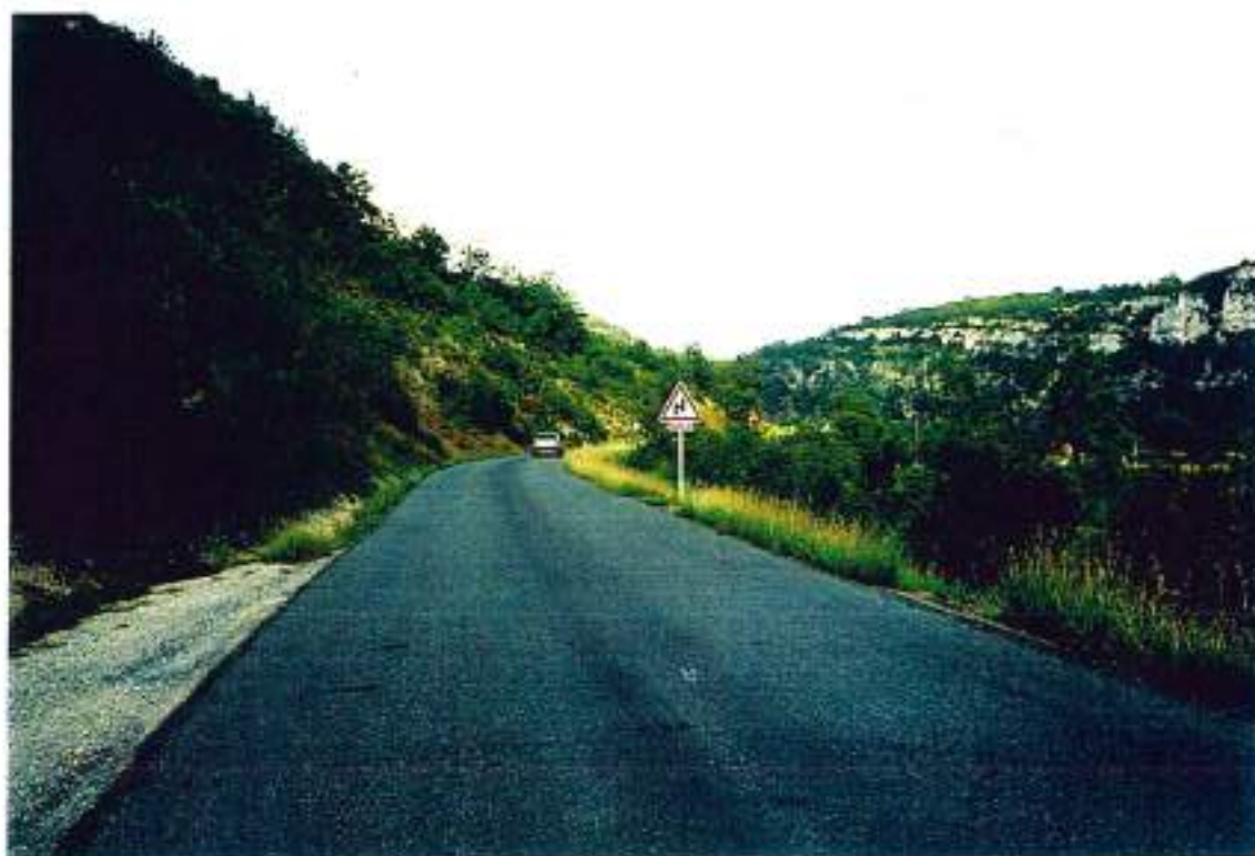
46-74 (n°15ter-15A)- Vallée du Célé- D41- Deuxième tronçon après le pont de Monteils ; chaussée de plus de 5,20m de large
