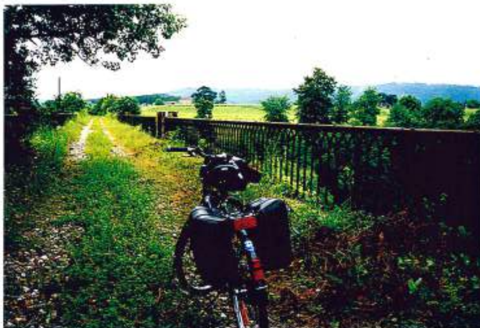
46-11 (n°7-1°-27)- Pont SNCF de Lacroze à Vire-sur-Lot : un site magnifique pour la future Voie Verte
