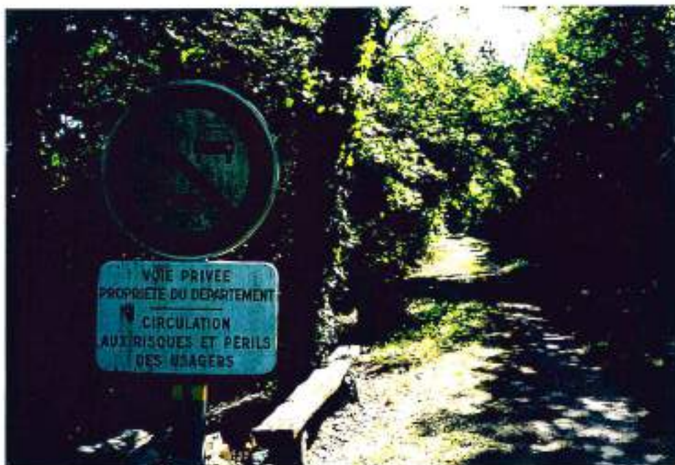
46-41 (n°10-28/28A)- Voie Verte existante de Douelle à Mercuès (5 km): le sentier au pied de Mercuès
