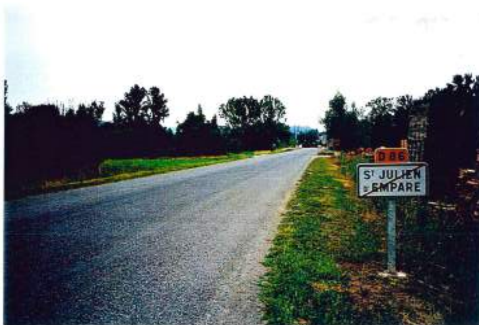
46-88 (n° 18-28A)- La D86 à St-Julien d'Empare, direction Capdenac : à sécuriser
