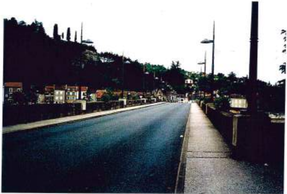
46-49 (n°12-15A)- Cahors- Pont Louis-Philippe , 14800 véh/j, aucun marquage au sol: à sécuriser
