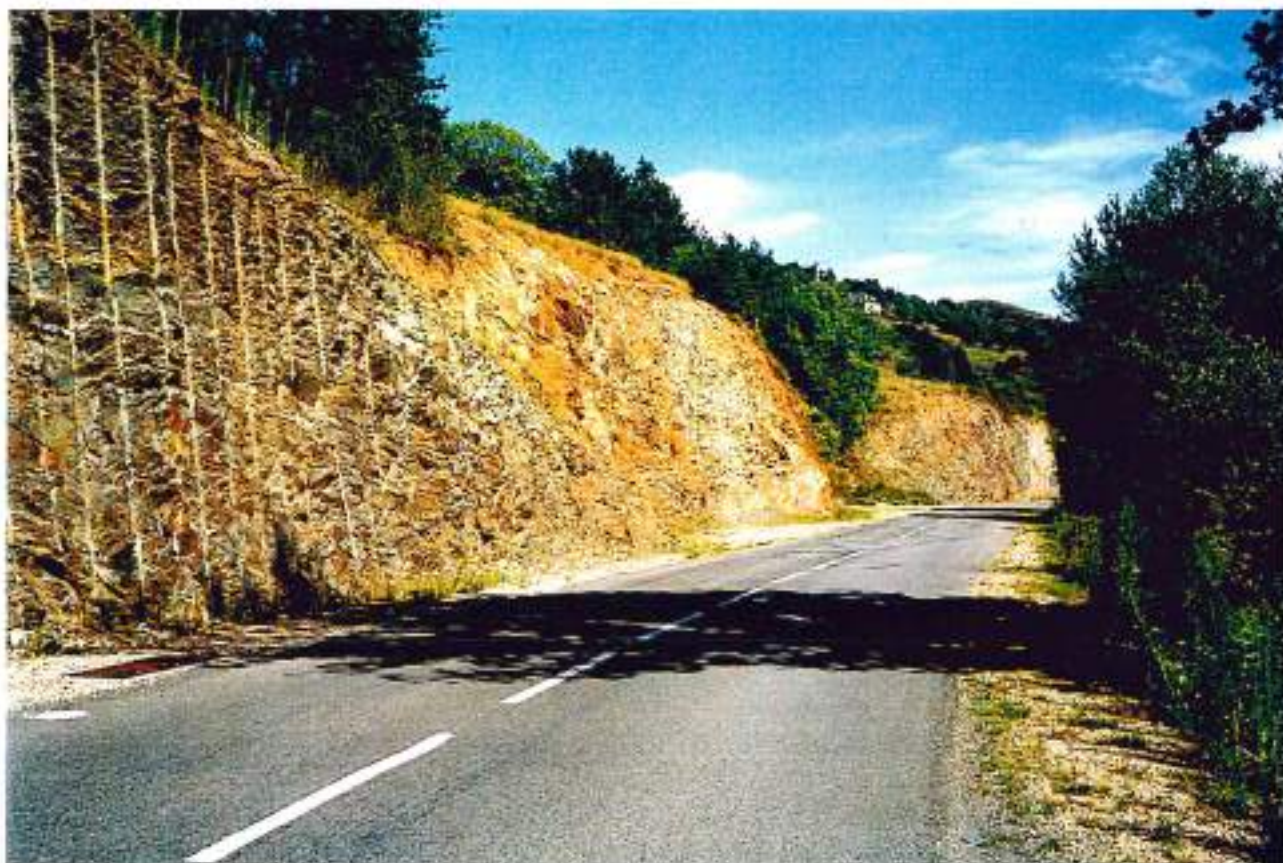
12-24 (n°21-24) et 15-2- La D141 après Vieillevie, avant Le Port (Cantal) : section élargie à 5,60m, sans sur-largeurs cyclables.
