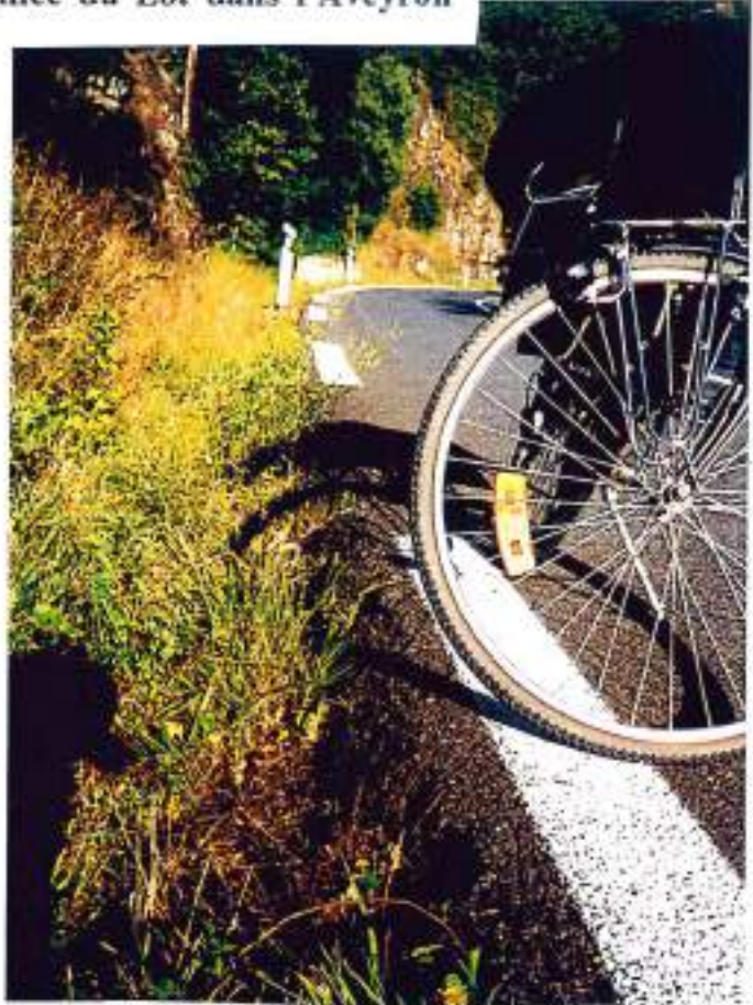
12-33 (n°22-8/8A) - D920 d'Entraygues à Estaing : entre Entraygues (panneau Les Gorges du Lot) et l'usine de Golin hac, fossé de 50 cm de profondeur au ras de la voie côté falaise! danger!
