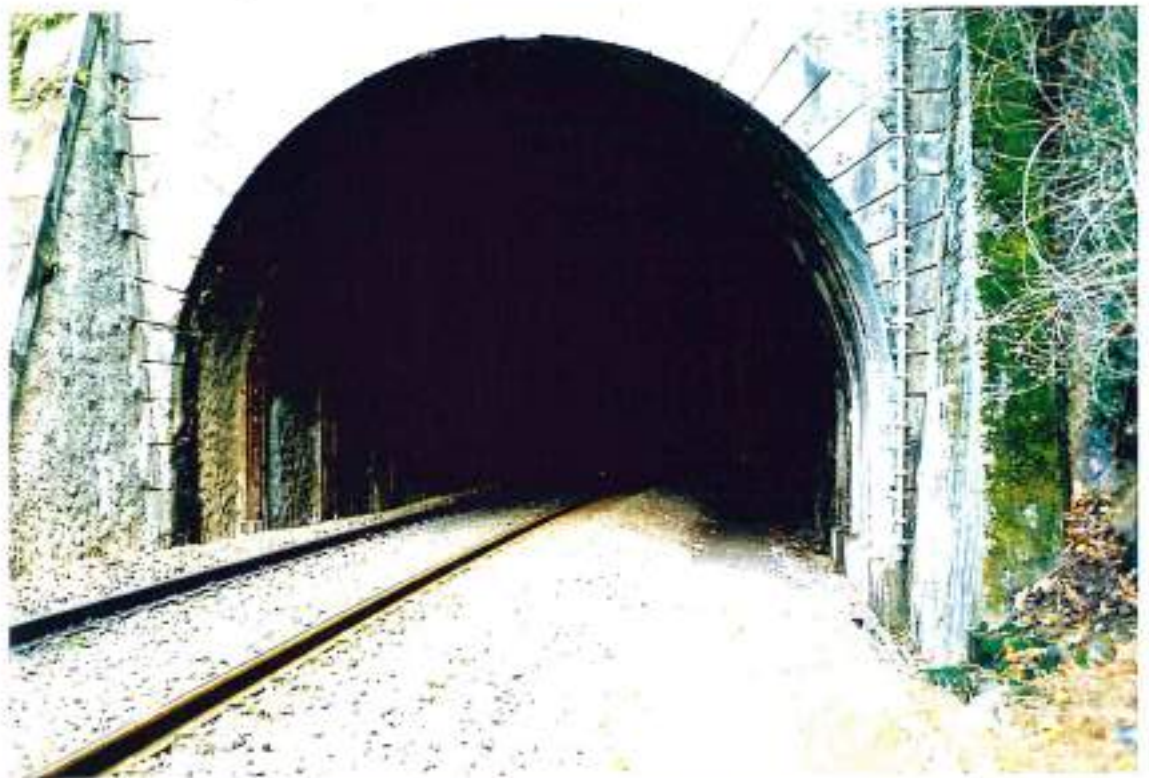
12-8 (n°20bis-12)- La voie ferrée Capdenac-Decazeville après Assier : l'entrée du tunnel après Vernet le Haut
