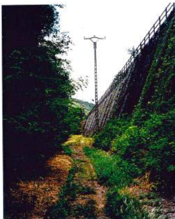
12-12 (n°19-35)- Le chemin au bord du Lot entre Coussieu (St-Martin-de-Bouillac) et l'ancienne écluse: ici revêtement à améliorer
