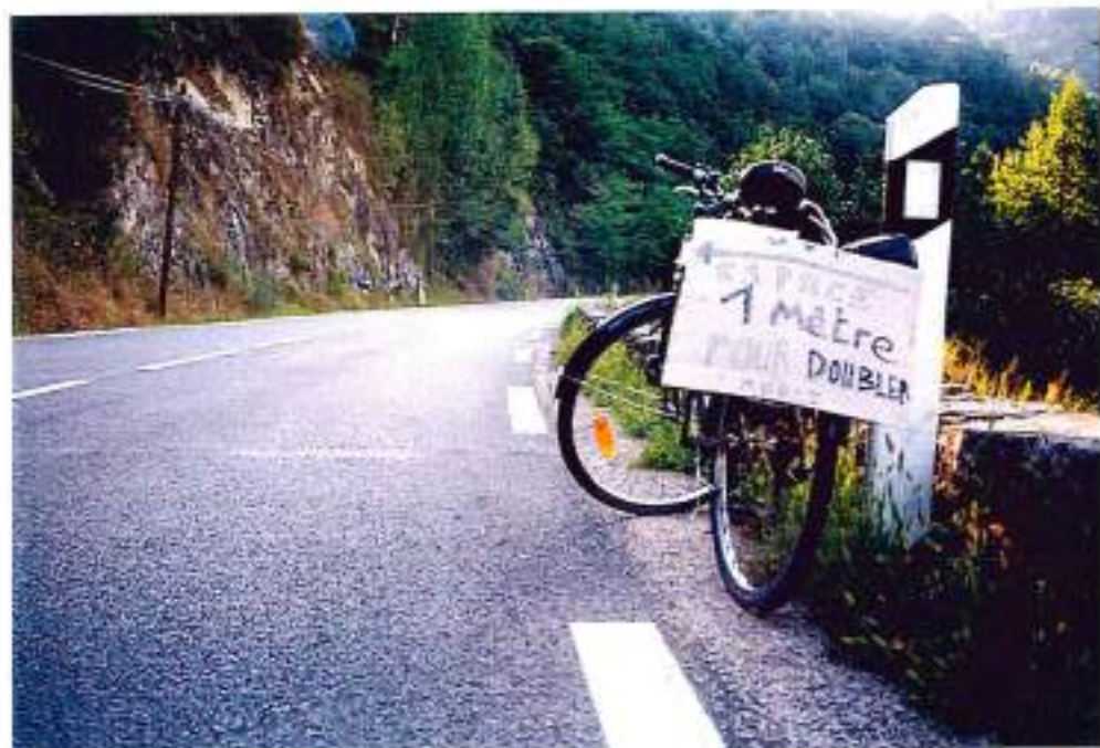
12-30 (n°22-8) - D920 d'Entraygues à Estaing : à Rodiez, sortie d'Entraygues, absence de bas-côté, ligne médiane discontinue dans le virage, et vélo avec panneau de sécurité!
