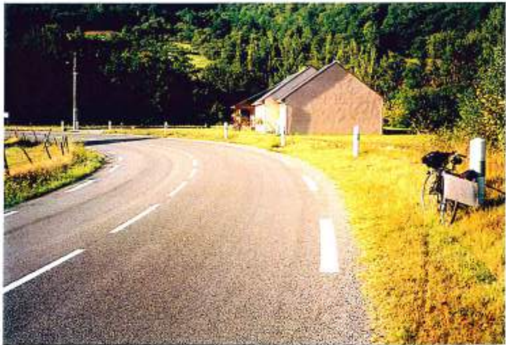
12-29 (n°22-5) - D920 d'Entraygues à Estaing : à la sortie d'Entraygues, files de 3,20m et 4,20m, ligne médiane discontinue dans le virage!
