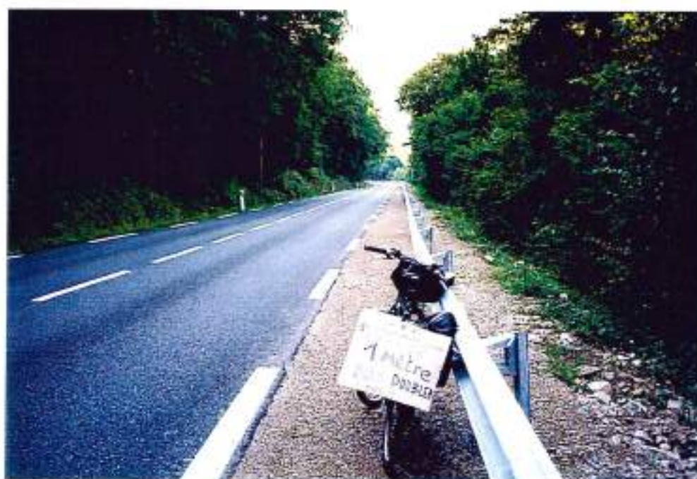
12-32 (n°22-14/14A) - D920 d'Entraygues à Estaing : à 3 km d'Entraygues, les Gorges du Lot entre Costes et l'usine de Golinhac, la place existait pour créer 1,50m de sur-largeur cyclable ou de piste protégée!
