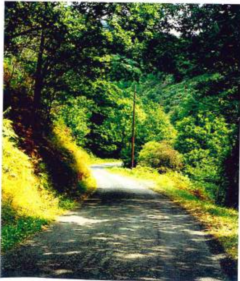
12-42 (n°25-23A) - La D509 après le pont de Pomayrols (dir. St-Laurent-d'Olt) : jolie route tranquille, étroite (ici chaussée de 3,50m) mais peu circulée
