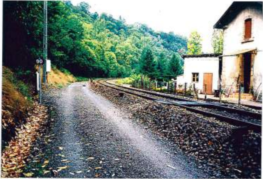
12-9 (n°20-35)- La voie ferrée Capdenac-Decazeville après Assier : le chemin parallèle existant déjà pour les véhicules SNCF au hameau La Rivière, sur plus de 500m
