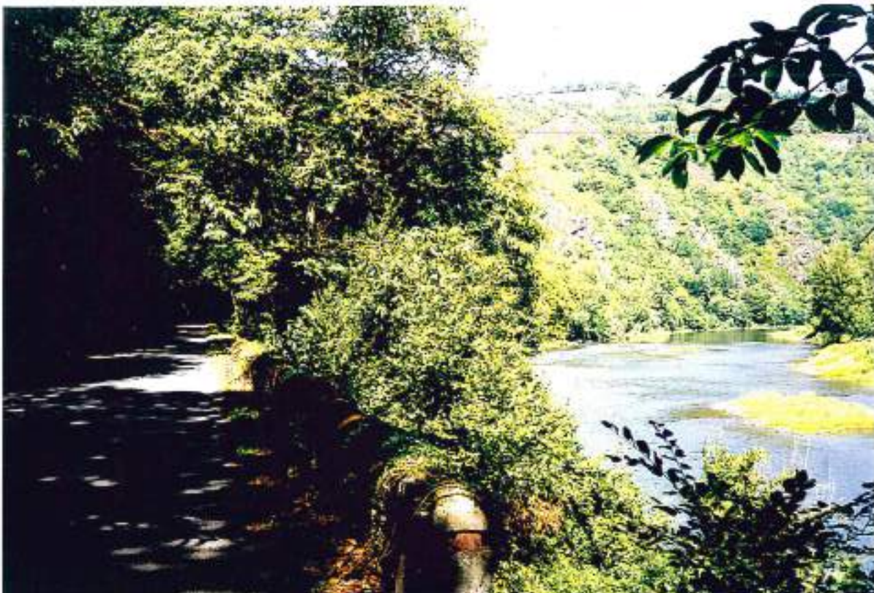
12-17 (n°21-20)- La D42 après Port-d'Agrès, 1 km avant St-Parthem : section de 800m à chaussée étroite (4,50m)
