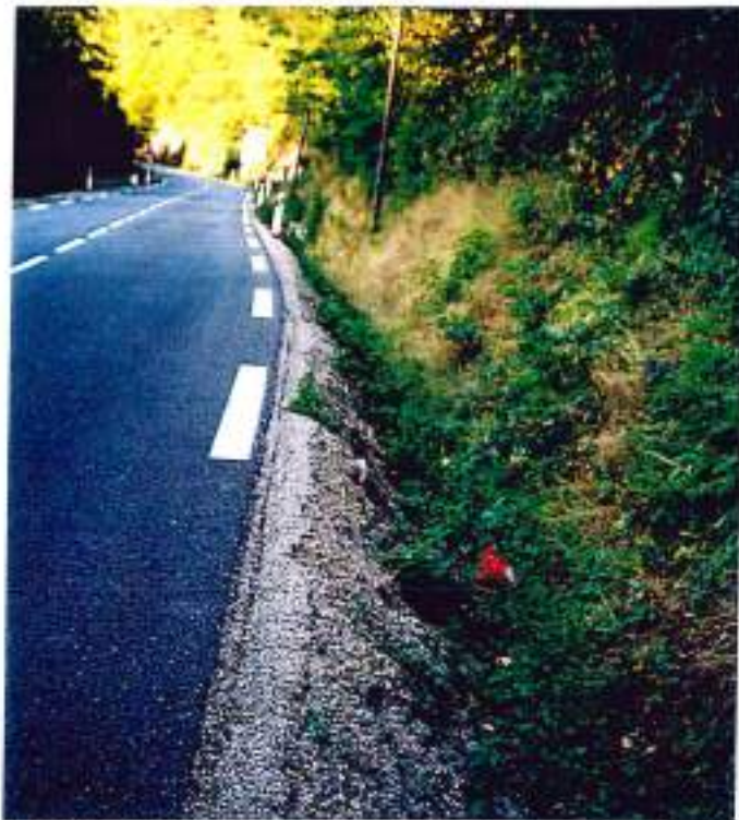
12-34 (n°22-14/14A) - D920 d'Entraygues à Estaing : entre Entraygues (panneau Les Gorges du Lot) et l'usine de Golin hac, fossé de 70 cm de profondeur au ras de la voie côté falaise! danger!
