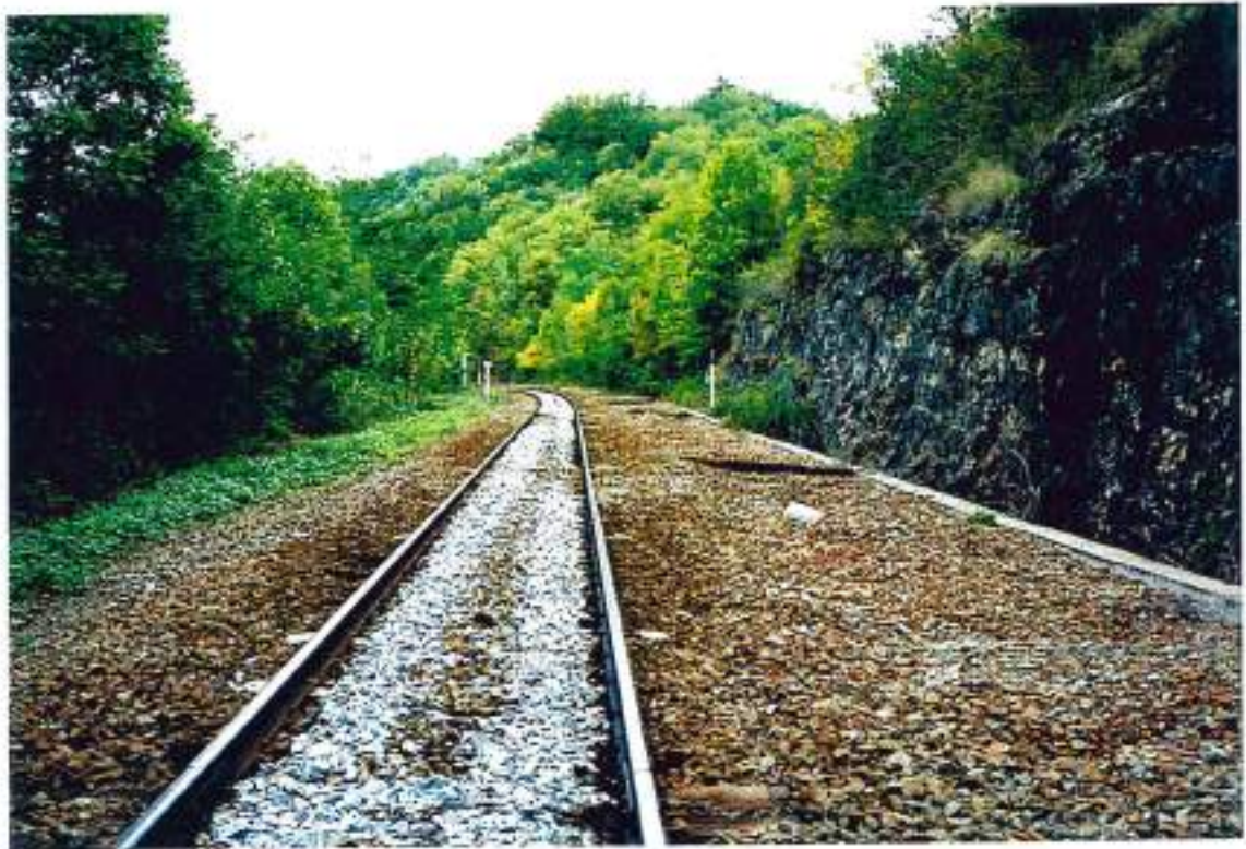
12-4 (n°17bis-36A)- La voie ferrée Figeac-Capdenac-Decazeville à Sourdille (au pied de Capdenac, direction Figeac): on voit les 5 mètres rendus disponibles par la suppression de l'une des deux voies.
