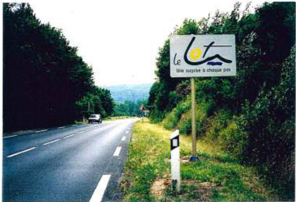
12-3 (n°19-2°-13)- La RN140 Capdenac-Penhot , avant Bouillac: l'entrée dans le Lot, plus de bas-côtés gravillonnés entre Bouillac et Capdenac (une mauvaise surprise)
